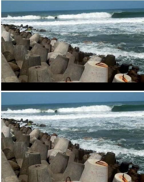
Gambar 2: Kaki Tiga Pemecah ombak Pantai Glagah Kulon Progo
