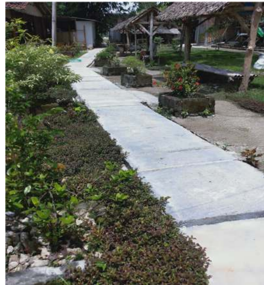
Gambar 5. Jalan Setapak Taman
